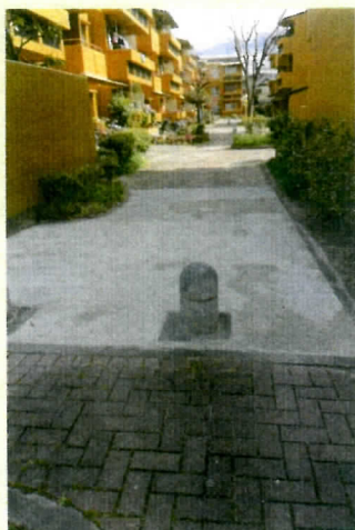
府宮城東住宅自治会からの声で、住宅内の老朽化通路を補修しました。
